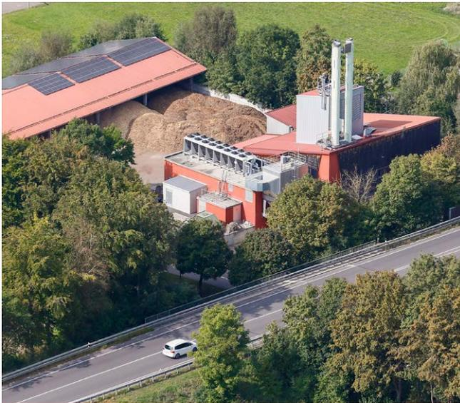
Das Biomasse Heizkraftwerk Aichach verwertet jährlich ca. 15 000 Tonnen Biomasse, um diese in Strom und Wärme umzuwandeln
